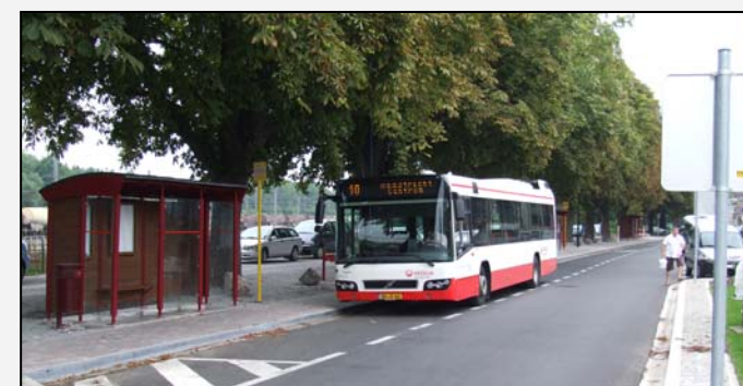
Visé, place des Déportés : couloir d'accostage des bus © ACTP
